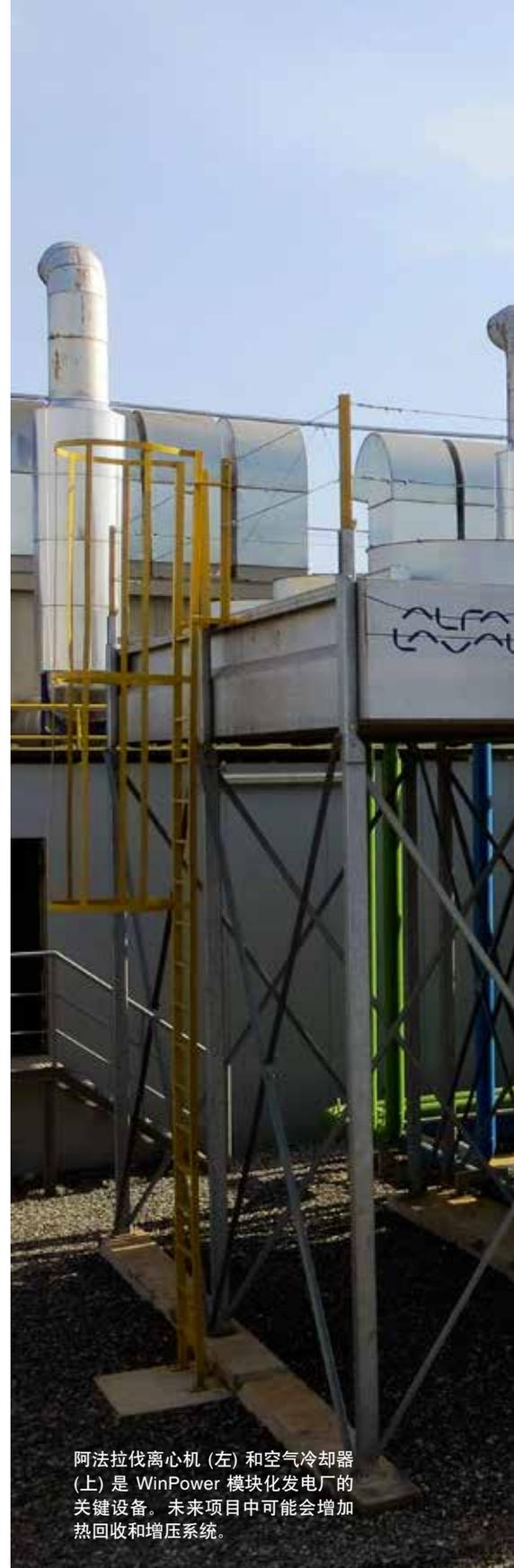
阿法拉伐离心机 (左) 和空气冷却器 (上) 是 WinPower 模块化发电厂的关键设备。未来项目中可能会增加热回收和增压系统。
