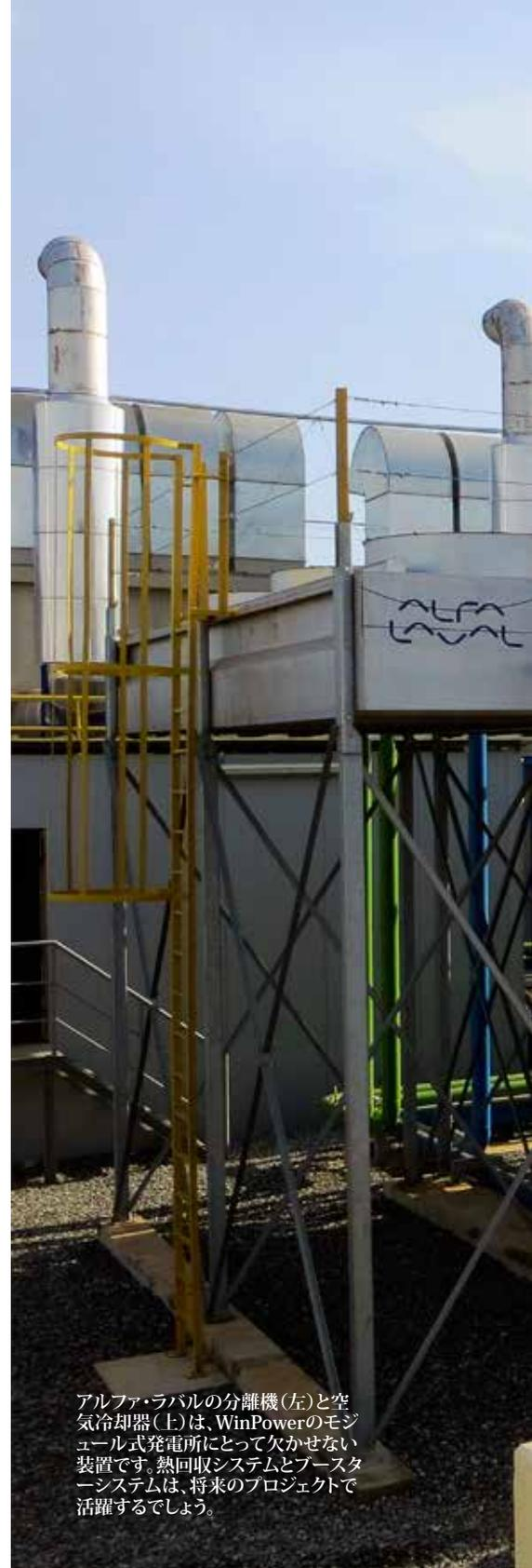
アルファ・ラバルの分離機(左)と空冷冷却器(上)は、WinPowerのモジュール式発電所にとって欠かせない装置です。熱回収システムとブースターシステムは、将来のプロジェクトで活躍するでしょう。
